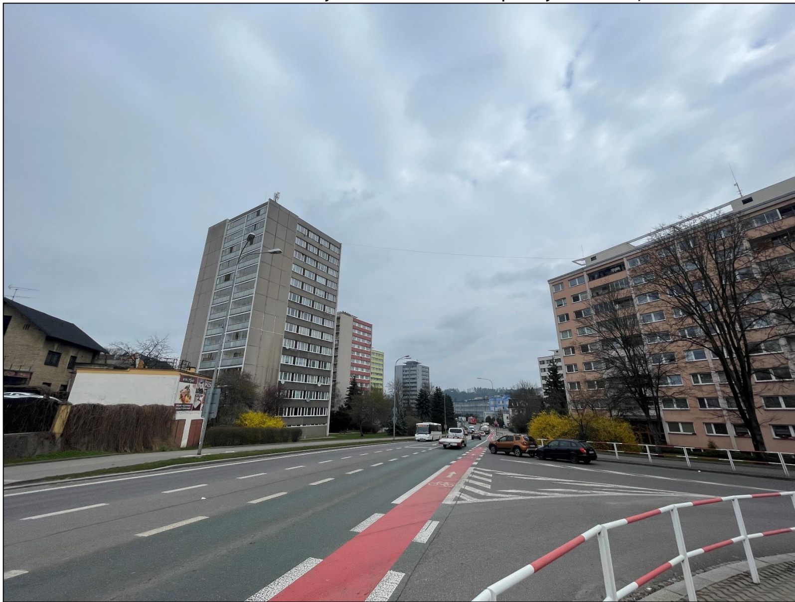
Obr. 23: Fotodokumentace zástavby v okolí kritického místa priority I v Náchodě, ul. Pražská
