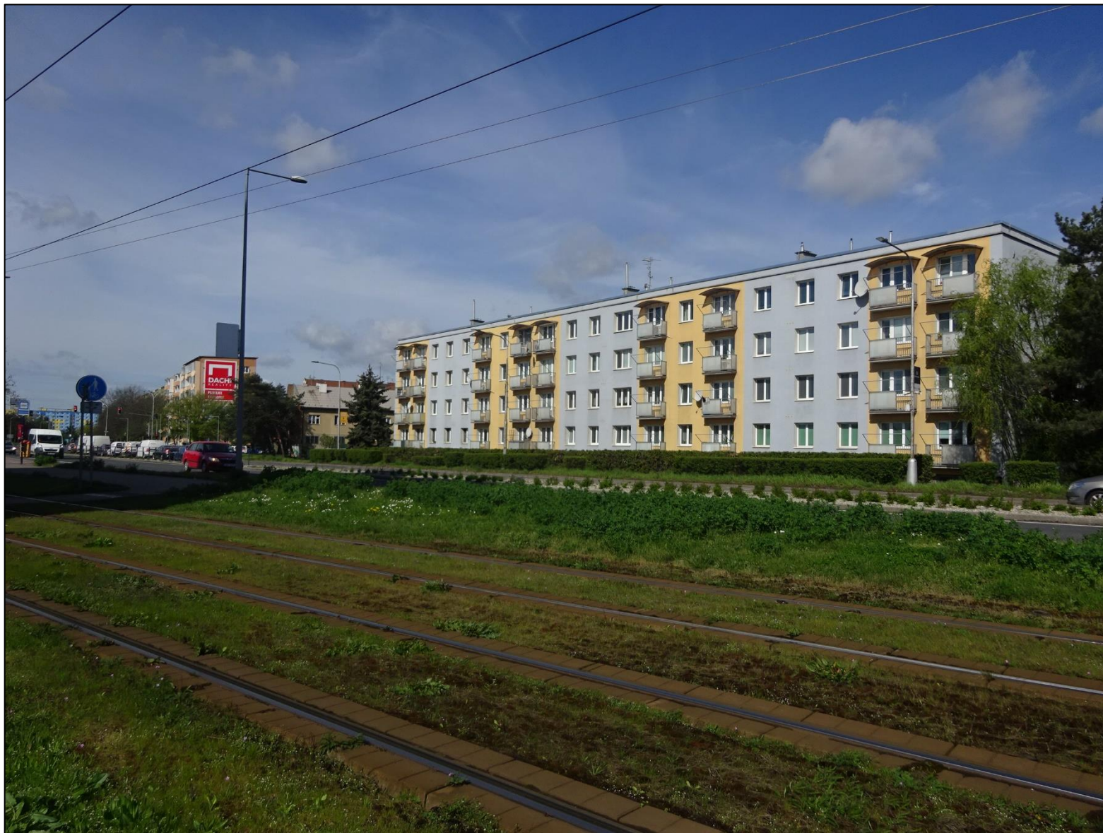
Obr. 12: Fotodokumentace zástavby v okolí kritického místa priority I v Olomouci v ulici Velkomoravská u komunikace I/35
