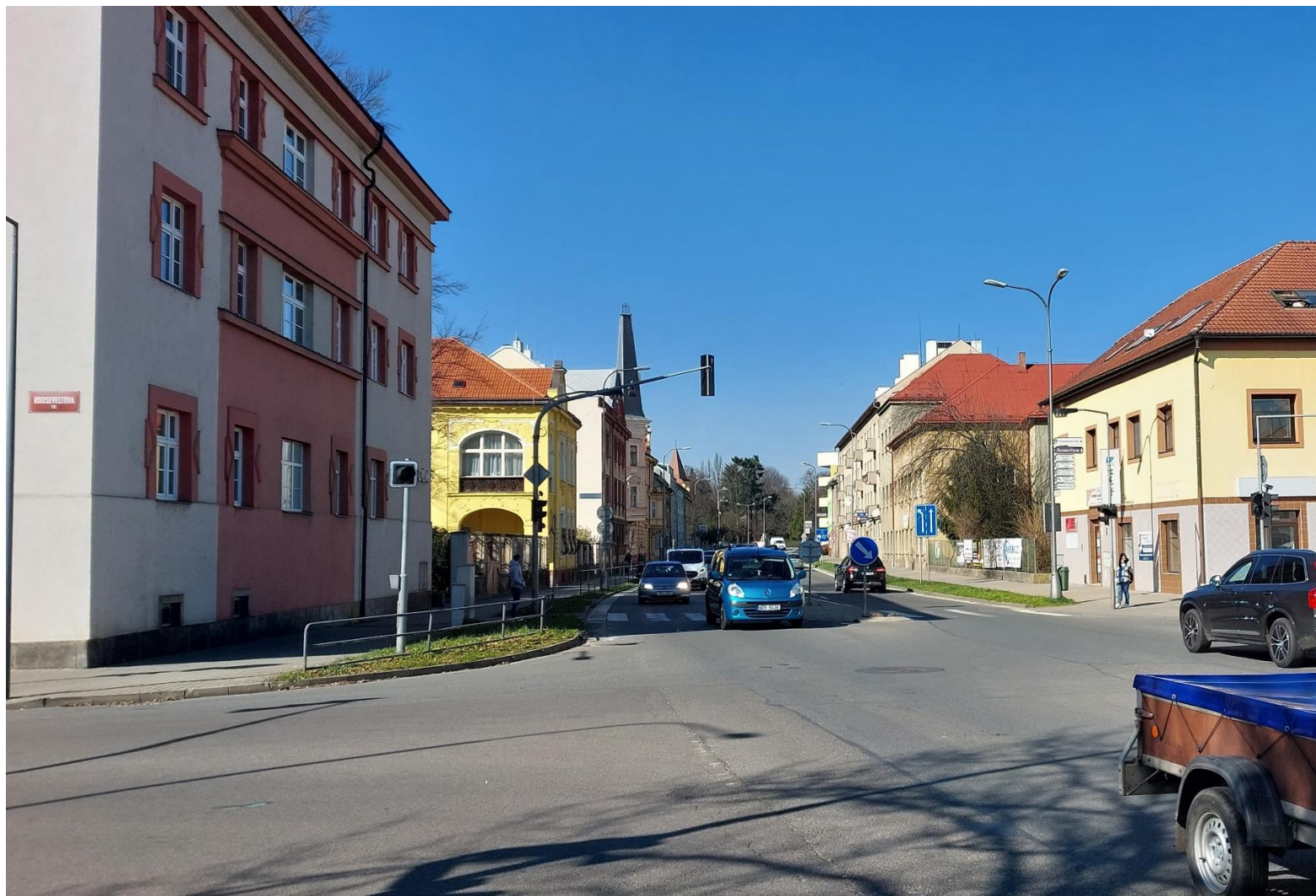
Obr. 13: Fotodokumentace zástavby v okolí kritického místa priority I v Chrudimi, ulice Palackého třída
