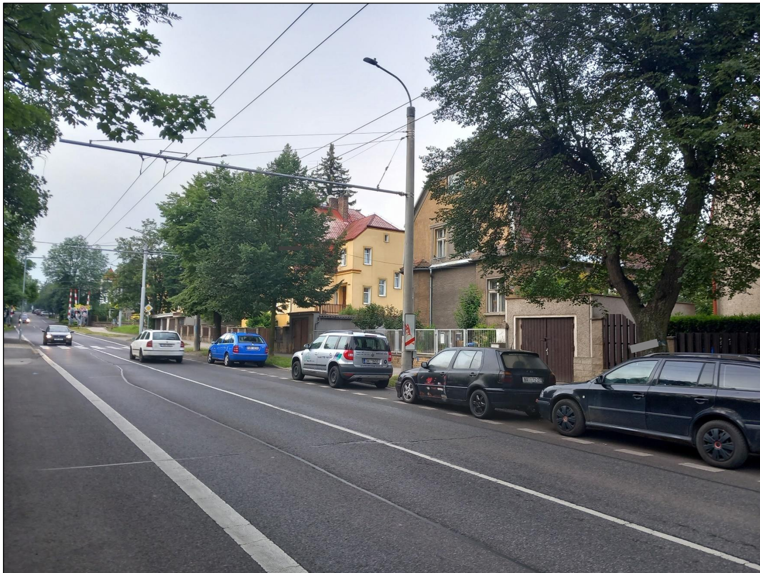
Obr. 22: Fotodokumentace zástavby v okolí kritického místa priority I v Teplicích, komunikace I/8
