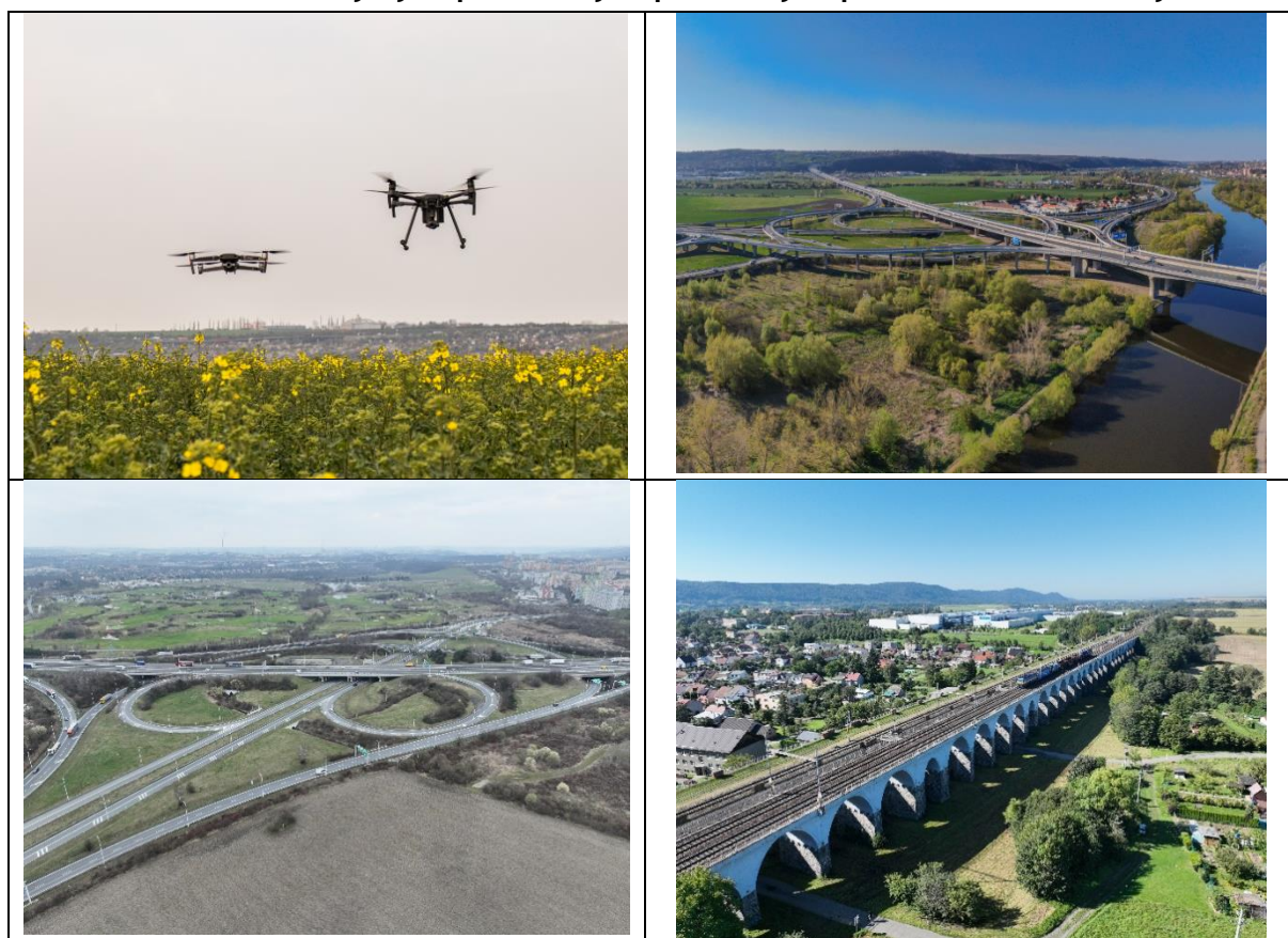
Obr. 2: Příklady výstupů leteckých prací a výstupů z akustické kamery
