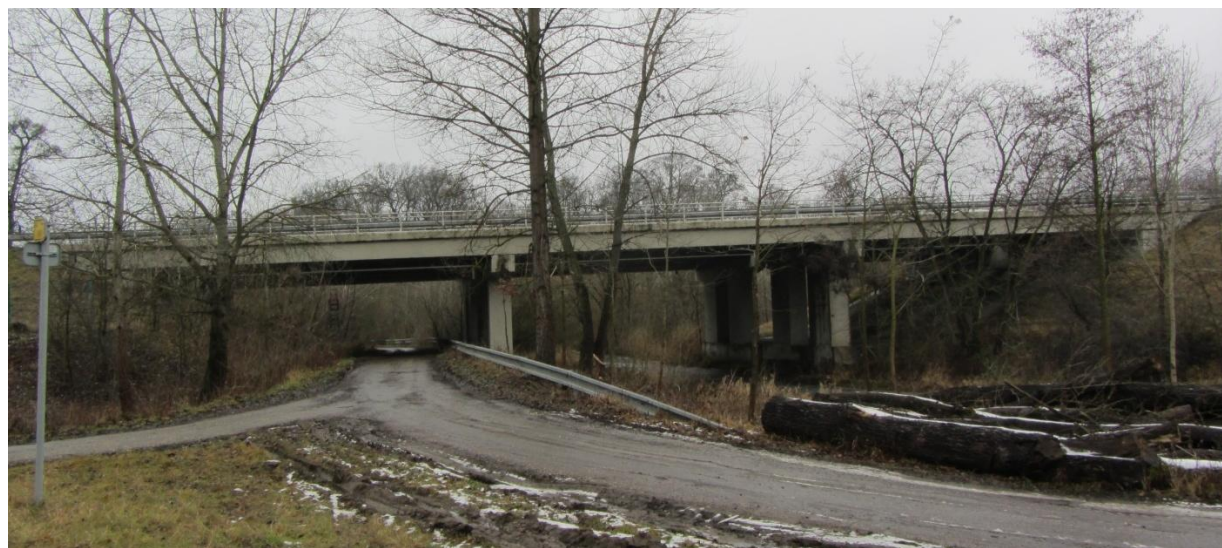
Obr. A2 Fotografie mostu – pohled na sledovanou část mostu
